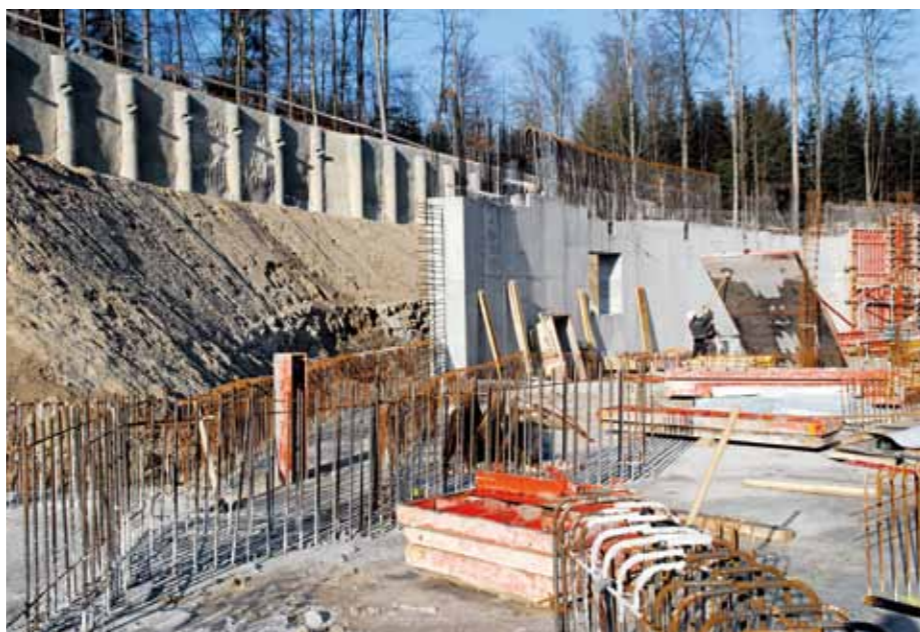
Der Hang ist gesichert, der Beton fliesst nun in Wände und Untergeschoss.
